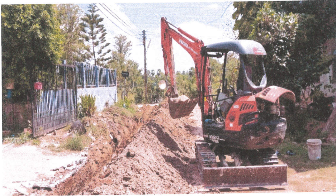
โครงการลงท่อระบายน้ำบ้านเชียงพัง หมู่ที่ ๓ เส้นจากบ้านนางชวนพิศไปบ้านนายสวน ชาวสวน บ้านเชียงพัง หมู่ที่ ๓ ตำบลนากว้าง อำเภอเมือง จังหวัดอุดรธานี ภาพขณะดำเนินการ
