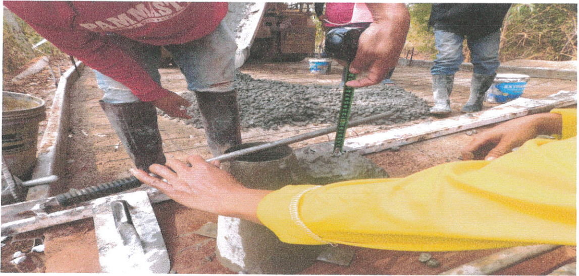
ภาพโครงการก่อสร้าง ถนน คสล. ม. ๖ บ้านดงสร้างควาย เส้นหน้าวัดข้างบ้าน นายวิสัย ถูกดี ไปบ้านนายสมชัย ถูกดี องค์การบริหารส่วนตำบลนาคว้าง ตำบลนาคว้าง อำเภอเมือง จังหวัดอุดรธานี ภาพขณะดำเนินการ
